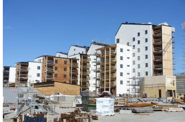
Vallen, Växjö Binderholz – 2017 8 storey CLT
